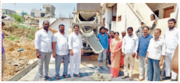
రోడ్డు పనులను పరిశీలిస్తున్న మున్సిపల్ చైర్మన్ దుర్గపూర్గా అశోక్‌గౌడ్
